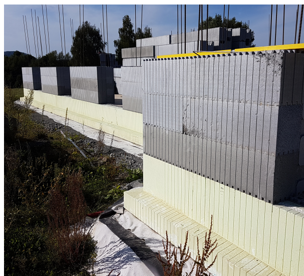
Obr. 2 Schématická konstrukce základové desky využívající přídatné tepelné izolace.
